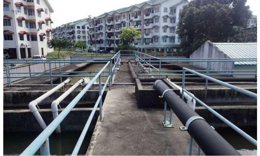
一般的な中規模STP (3,500PE)
