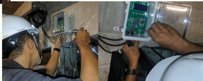
センサー制御部とセンサーの接続・電源接続
