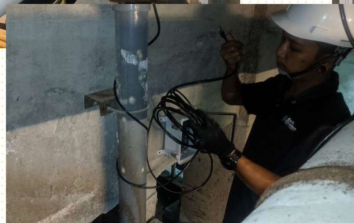
センサー制御部とセンサーの接続・電源接続
