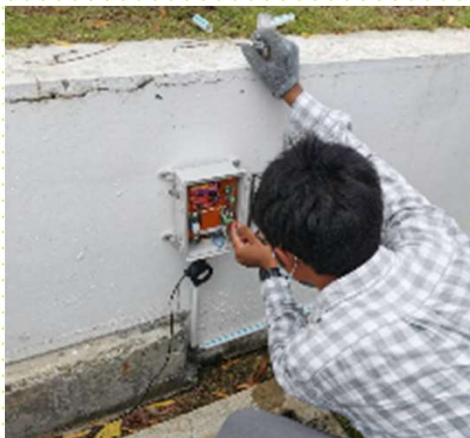
IoTセンサー取付け
