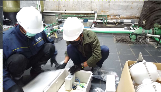
IoT監視システム制御盤の設置
