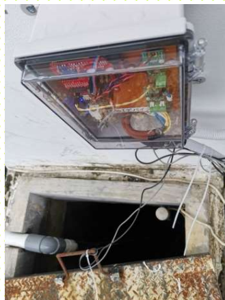
IoTセンサー取付け
