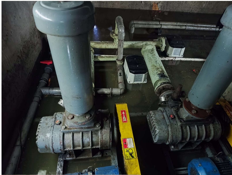
地下駐車場の浄化槽
