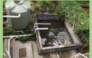
【写真: 下水処理設備】
