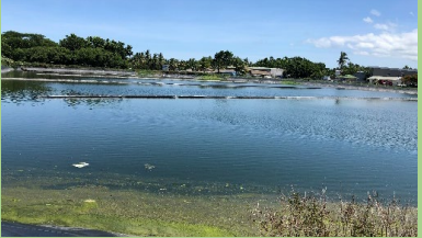
【写真: ポンプ場(上), 再生水貯留池(下)】
