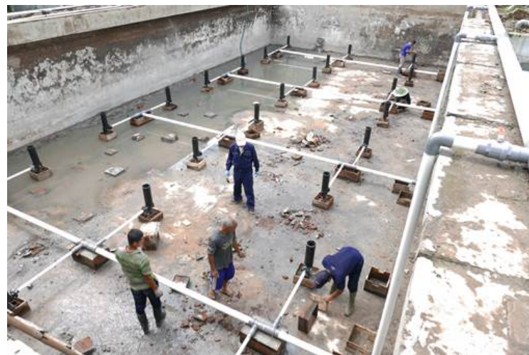
エアレーター・配管の設置②
