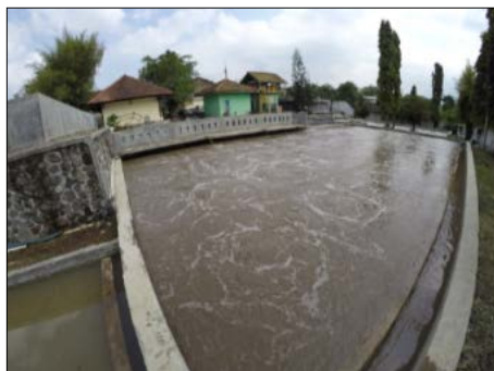
ディフューザーによる排水処理の状況(上:A系統、下:B系統)
