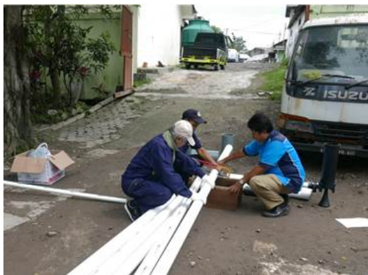
フランジの接続・空気配管の加工
