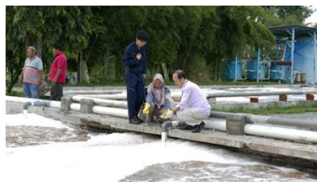
送風量調整・水質測定
