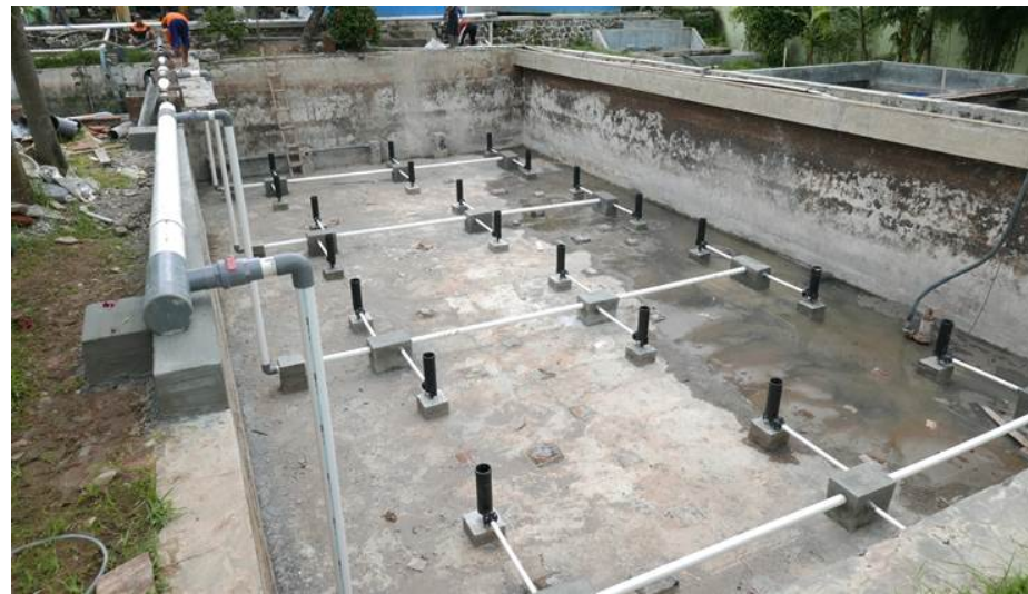
エアレーター・配管の設置③(完了)
