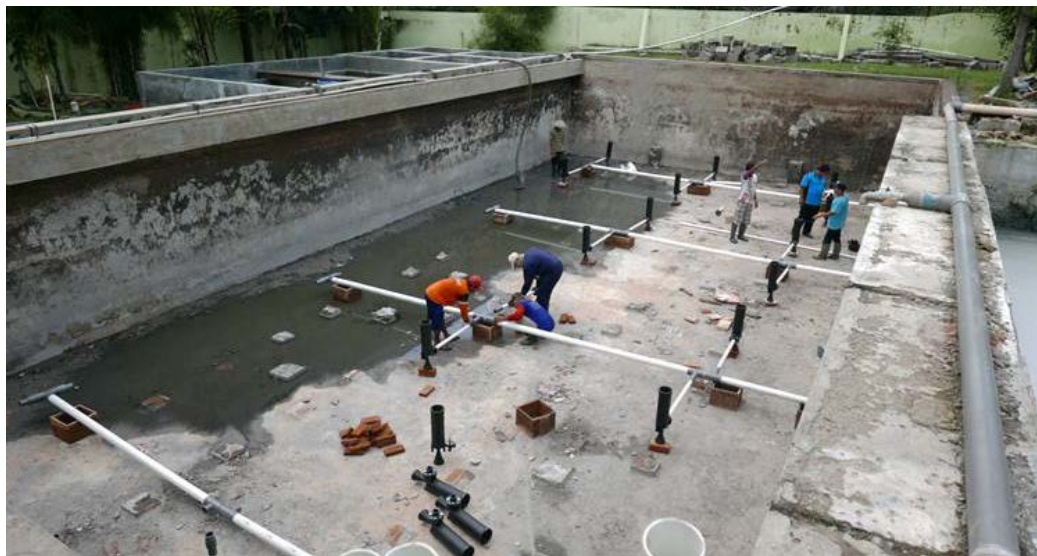
エアレーター・配管の設置①
