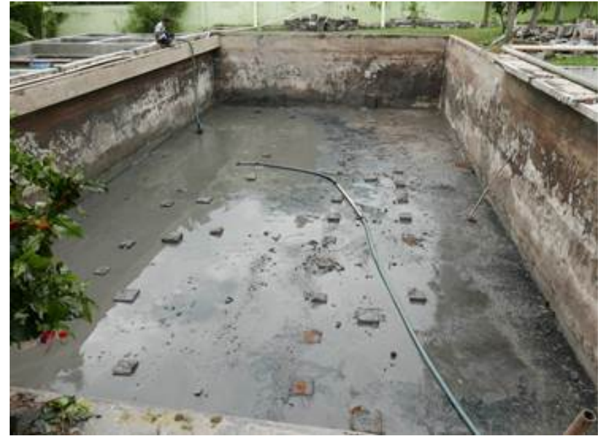
ベースコンクリートの撤去
