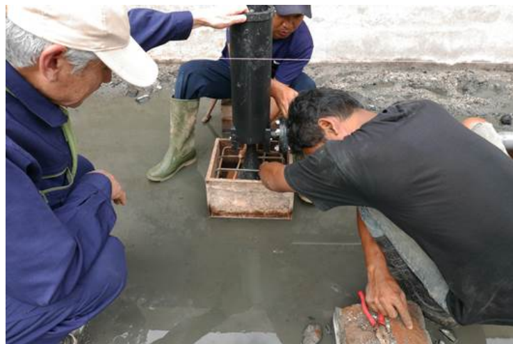
エアレーター固定工事(浮上対策)
