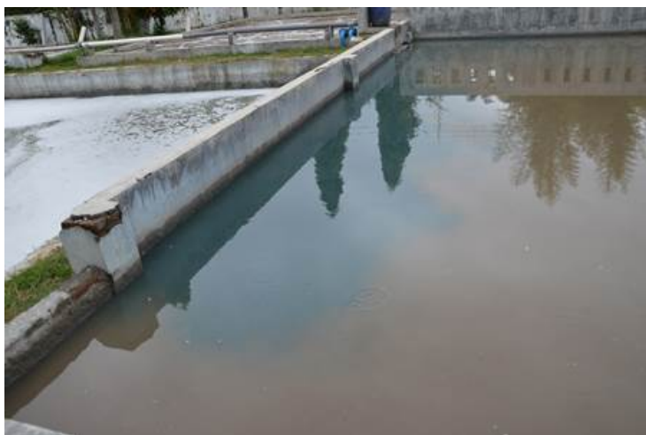
調整槽での不完全な混合
