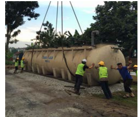
浄化槽本体の設置
