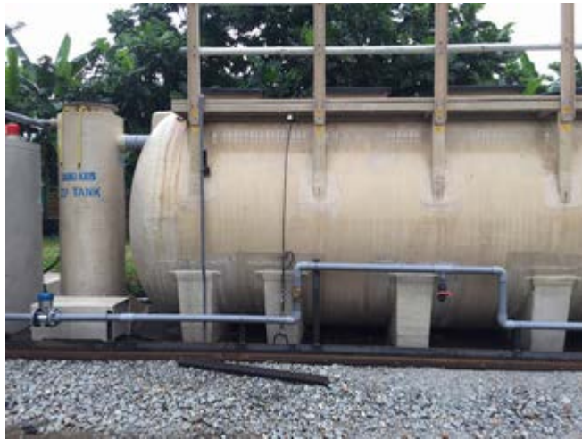
放流側配管(放流槽、採水バルブ)
