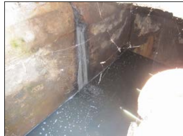
同現場の放流水
