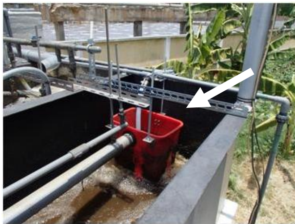
硝化液循環ライン増設
