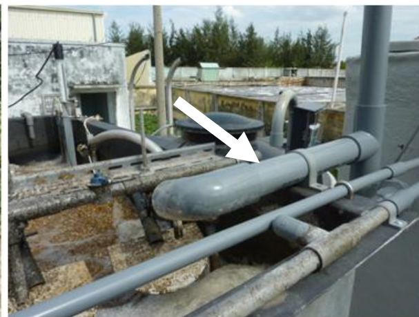
脱窒処理水移送ライン増設
