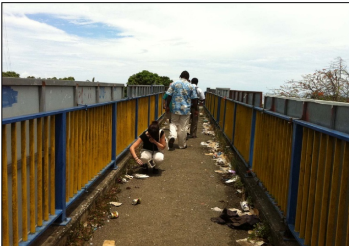
【写真1：屋外排泄に利用される歩道橋】
