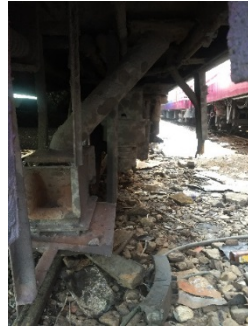
水洗トイレが設置されているが 未処理のまま垂れ流しの状態が続いている
