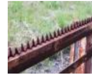
鉄道インフラへの影響 (腐食)
