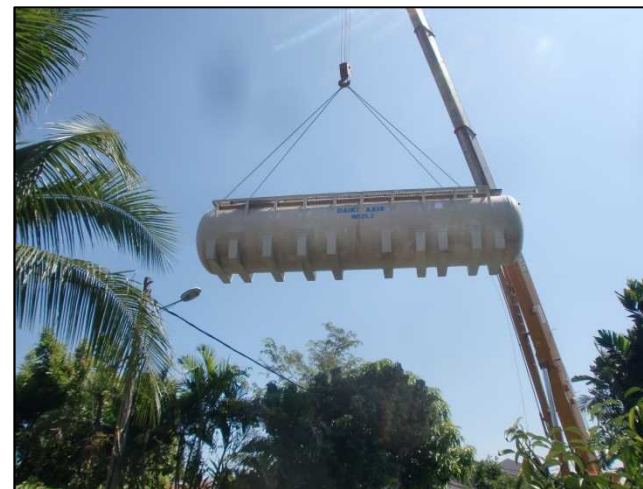
レッカー吊り上げ
