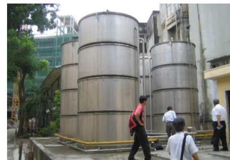
<排水処理施設> 後方は建築中の病棟
