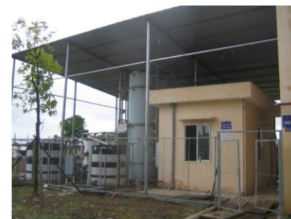
<排水処理施設>
