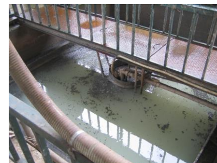
<沈殿槽の状況>
