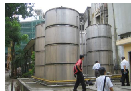
<排水処理施設> 後方は建築中の病棟
