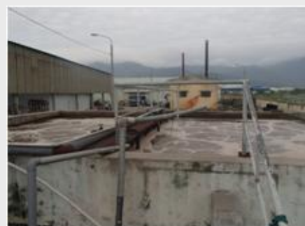
接触バッキ槽
