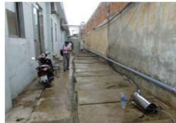
水質の悪い施設 沈降分離のみ
