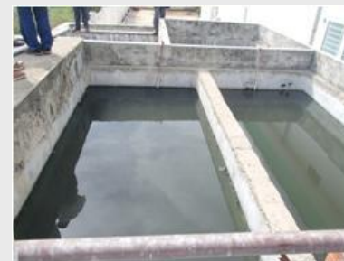
電気代削減でバッキ処理 しない排水処理施設
