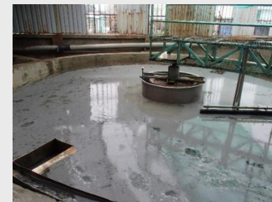
汚泥引抜不足による 汚泥の流出
