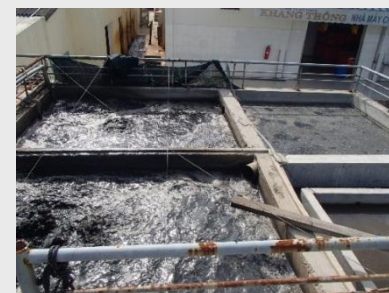
DO不足・不適切汚泥管理 により黒色に変色した バッキ槽の排水
