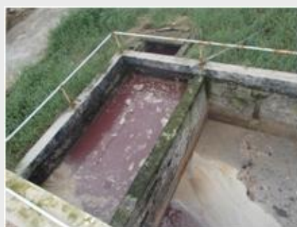
左:油水分離槽 右:原水調整槽
