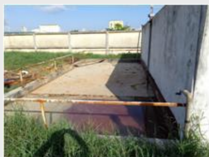
手前:油水分離槽 奥:原水調整槽
