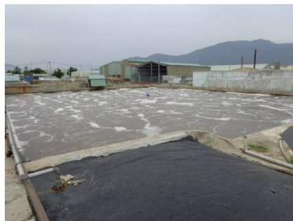
中央排水処理場 バッキ槽
