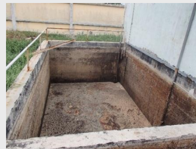
ゴミと汚泥が堆積する 原水調整槽
