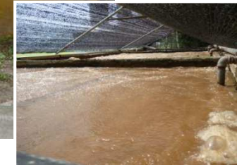
<活性汚泥槽内>
