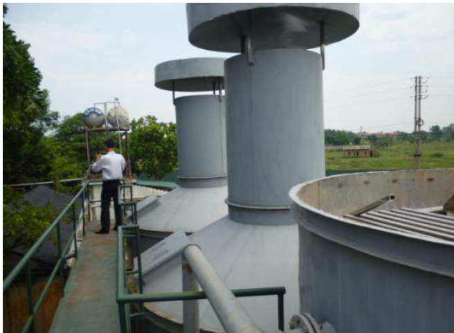
<散水ろ床装置>
