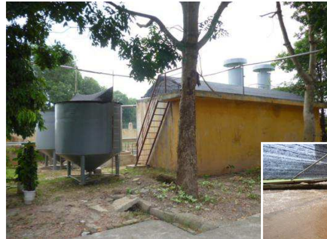
<活性汚泥槽と沈殿槽>
