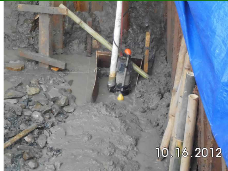
⑥釜場ポンプ(地下水汲み上げ)
