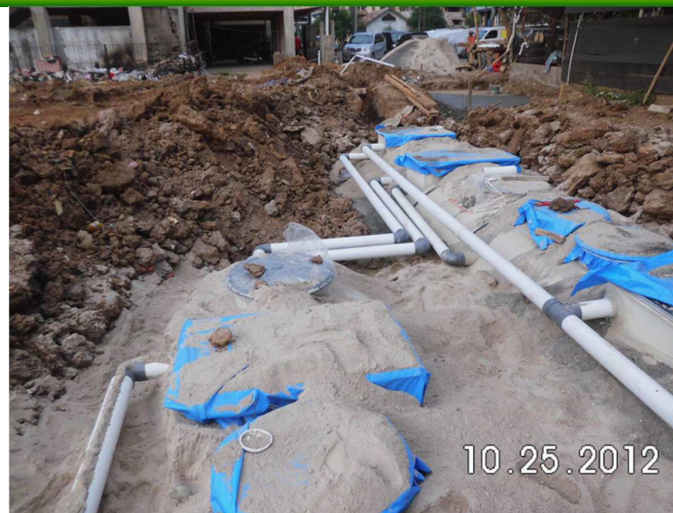
30槽外配管の水平チェック
