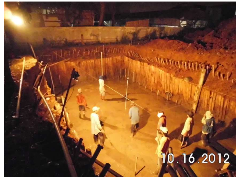
⑧捨てコンクリート工事:深さチェック
