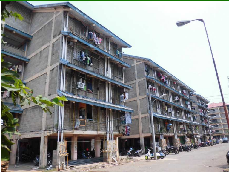
①設置現場の公団住宅
