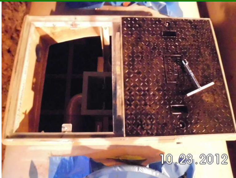
25浄化槽設置:水平チェック
