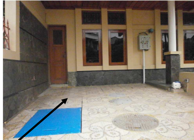
駐車場に設置
