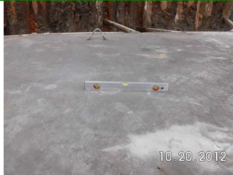
⑭コンクリート打設工事:水平チェック
