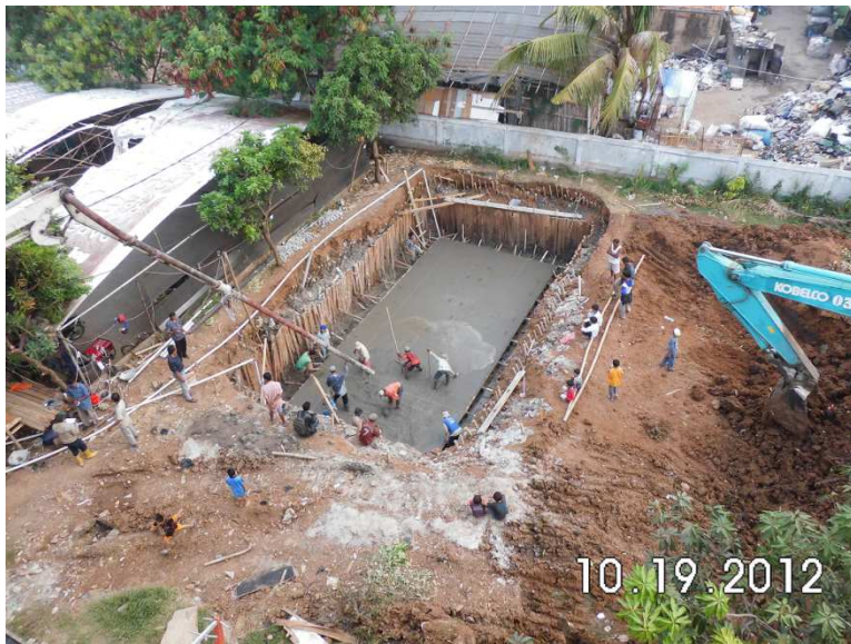
⑪コンクリート打設工事
