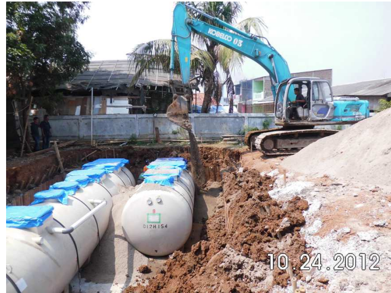
28埋め戻し(良質土)
