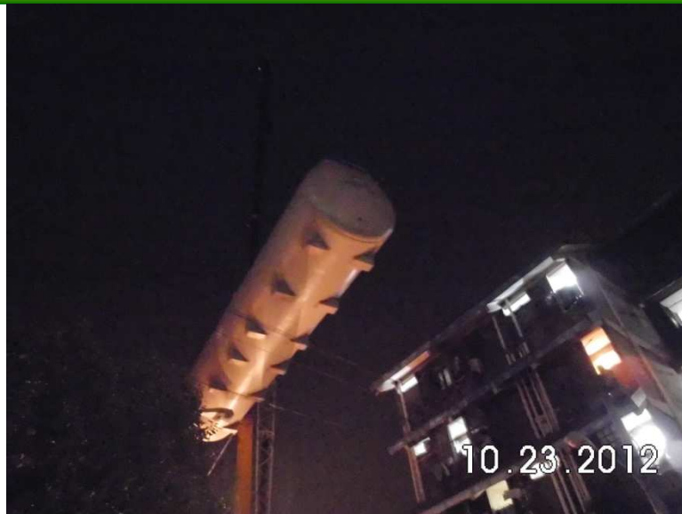
21浄化槽吊上げ
