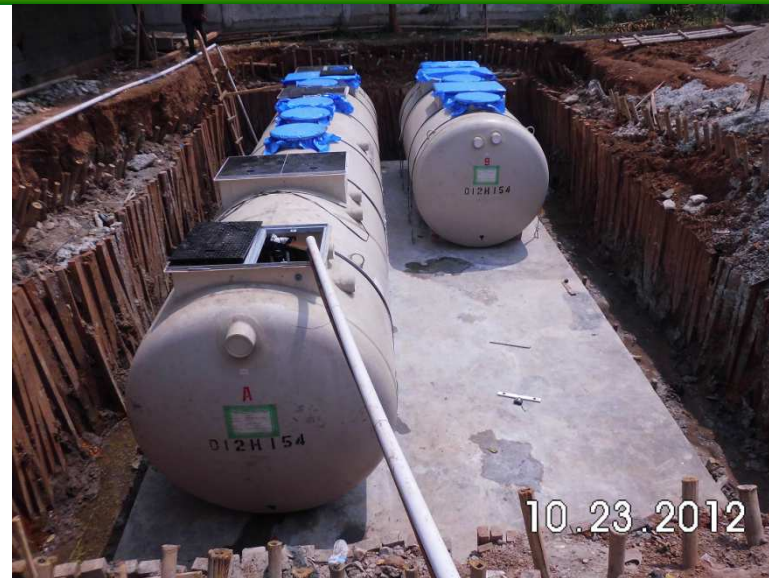
26浄化槽の水張り
