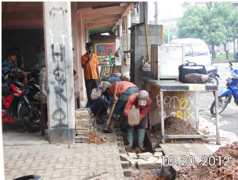
⑮雑排水配管の掘削工事
