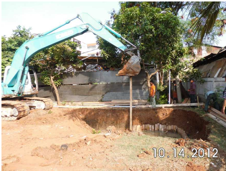
③掘削・支保工事
