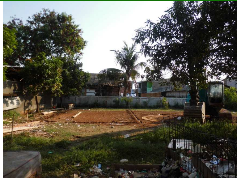
②浄化槽設置場所
