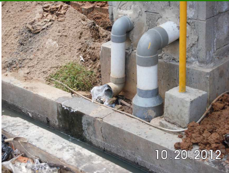
⑰既設配管:し尿(埋設)、雑排水(側溝)
