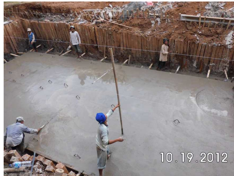
⑫コンクリート打設工事: 深さチェック
