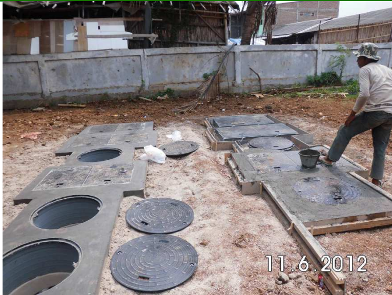
41マンホール周辺コンクリート打設
