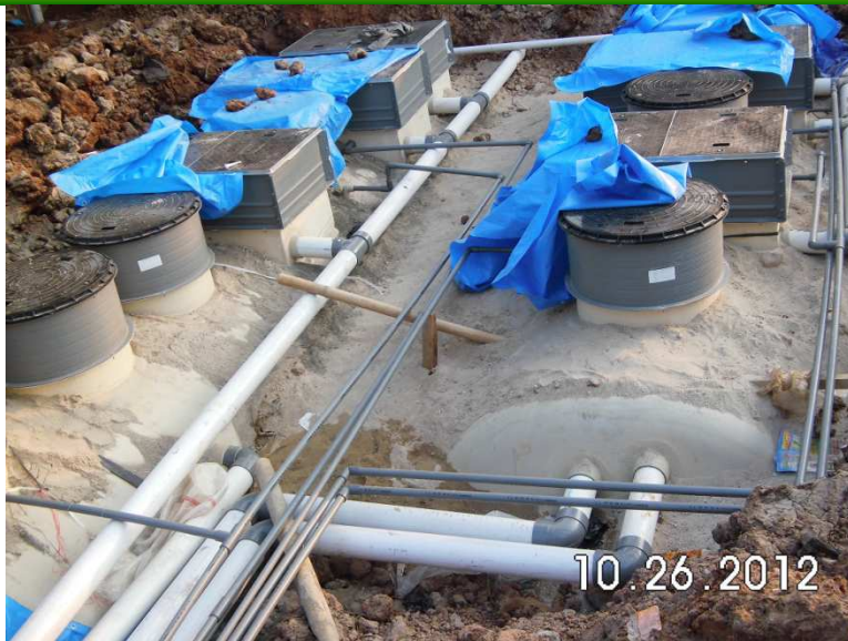
33配管電気工事
