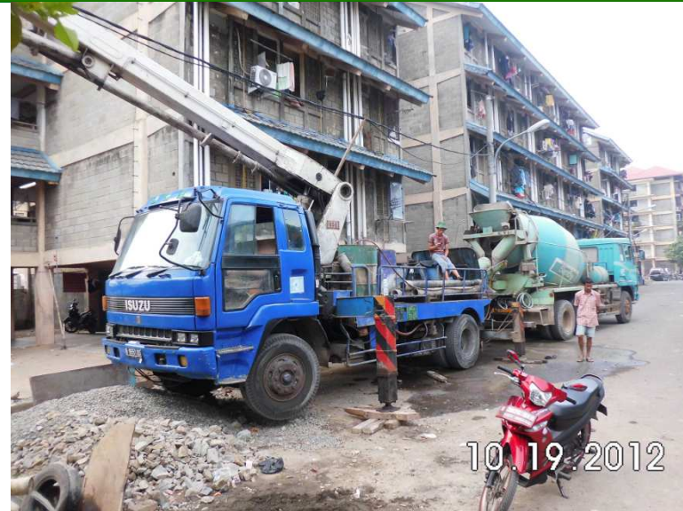
⑩コンクリート打設工事(ミキサー車・ポンプ車)
