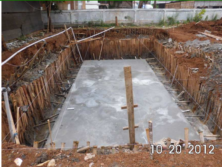
⑬コンクリート打設工事
