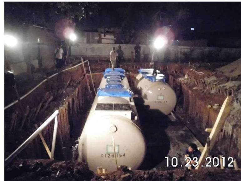
24浄化槽設置完了
