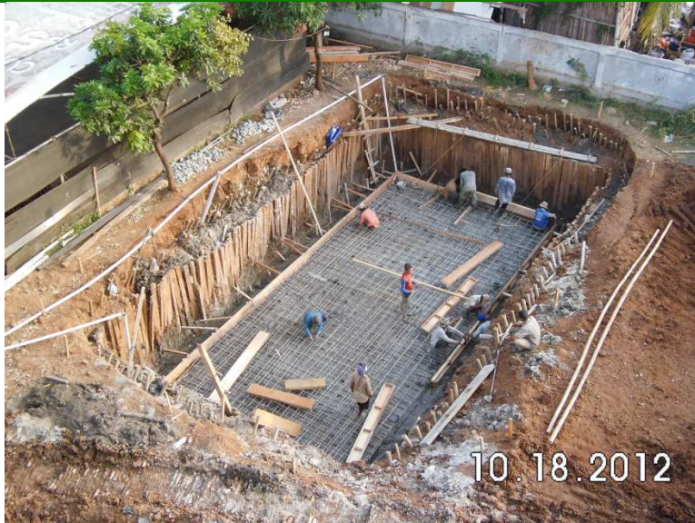
⑨鉄筋・型枠工事
