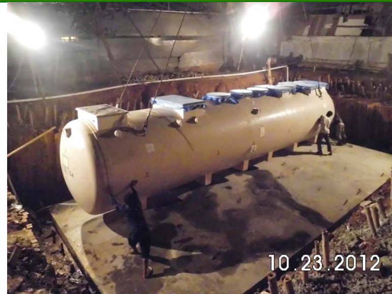
22浄化槽据え置き
