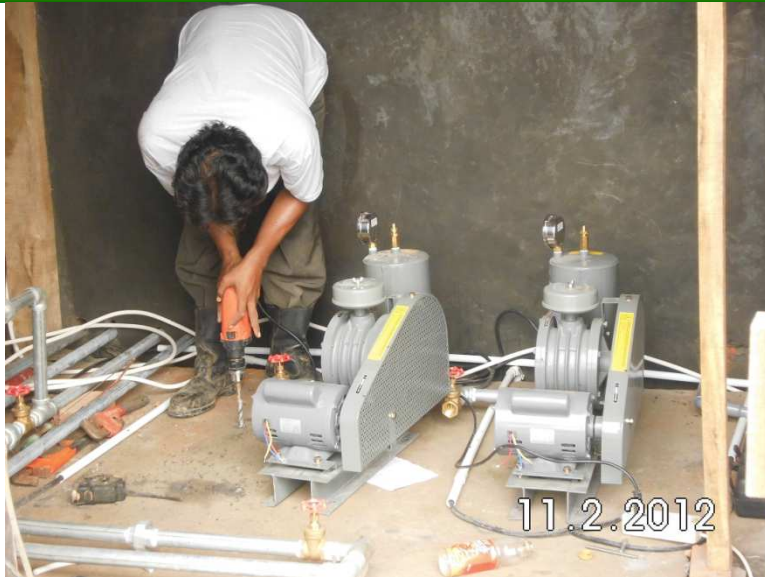
37ブロワ据付工事
