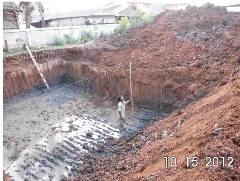
④掘削深さチェック
