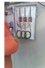
現場通信装置 設置状況
