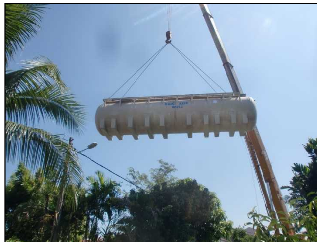
レッカー吊り上げ
