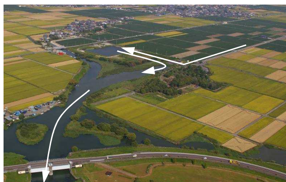
河川直接浄化事業の例(植生浄化)
