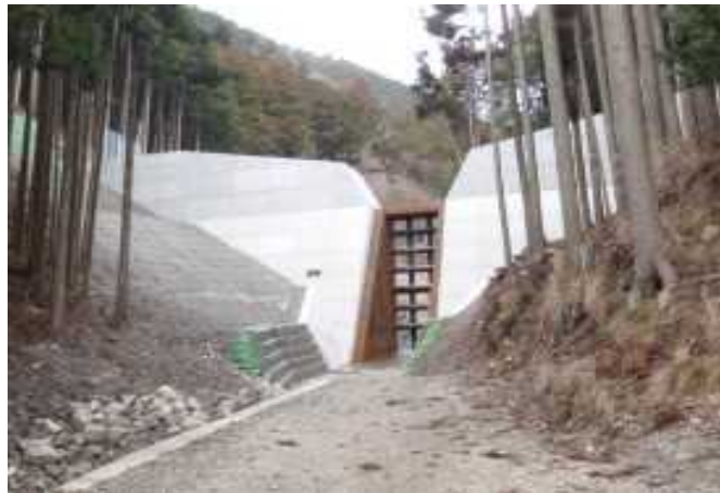
日野谷川堰堤（甲賀市）
