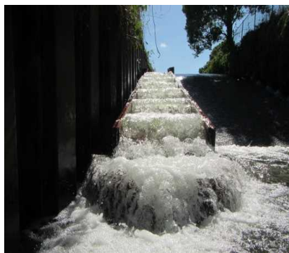
2019年度に設置した際の魚道
