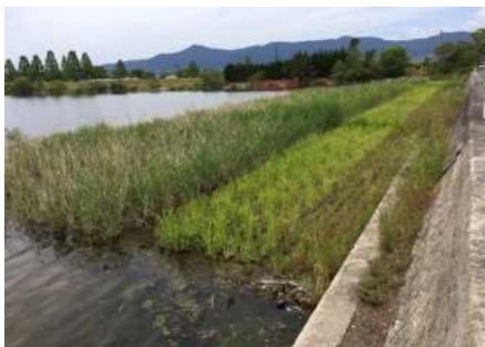
底質改善対策（覆土工・植生工）
