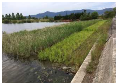
底質改善対策（覆土工・植生工）
