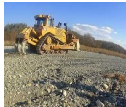
細粒分の流下促進によるアユの産卵環境の改善のための愛知川固定化砂州におけるアーモークート破壊（河床耕耘）事業
