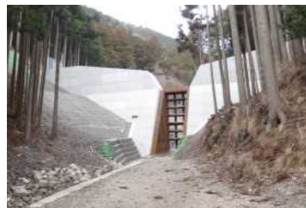
日野谷川堰堤（甲賀市）
