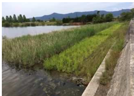
底質改善対策（覆土工・植生工）
