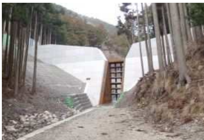
日野谷川堰堤（甲賀市）
