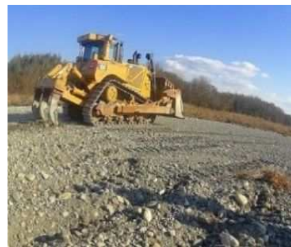
細粒分の流下促進によるアユの産卵環境の改善のための愛知川固定化砂州におけるアーマーコート破壊（河床耕耘）事業
