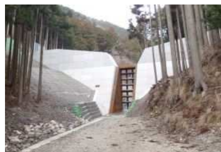
日野谷川堰堤（甲賀市）
