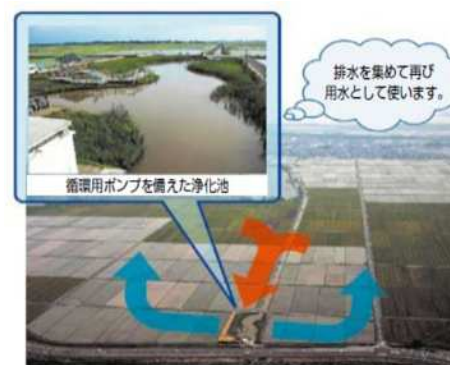
循環かんがい施設（木浜地区）
