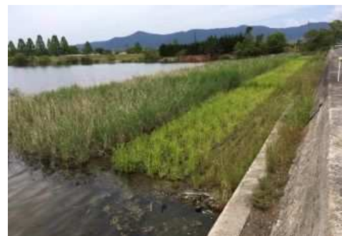
底質改善対策（覆土工・植生工）
