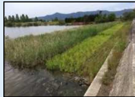
底質改善対策（覆土工・植生工）
