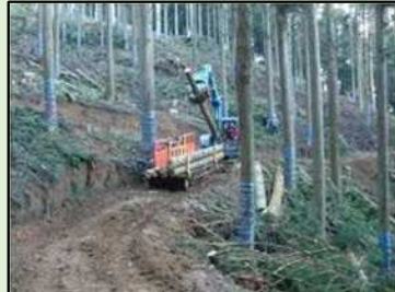
間伐施工地（長浜市）
