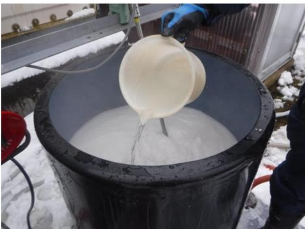
温泉排水へ消石灰投入後攪拌、リン酸液添加
