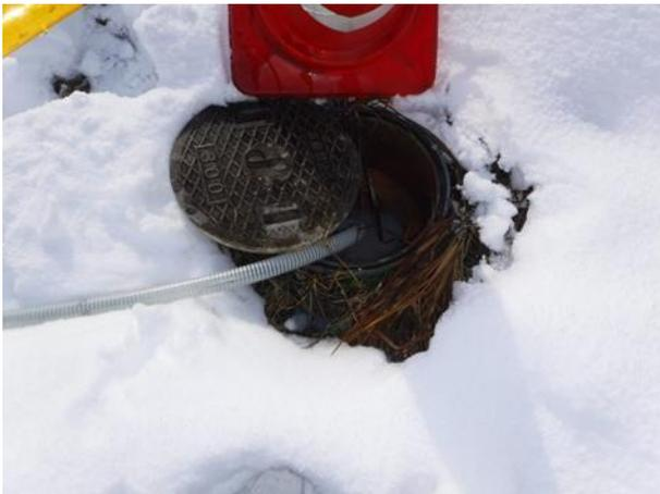
pH 調整タンクから排水溝への排水
