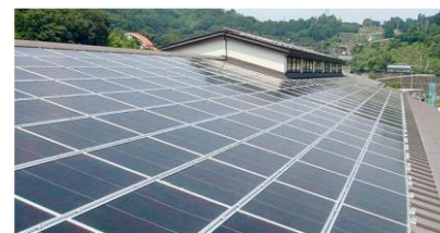
屋根に太陽光パネルを設置
