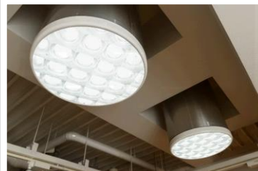
自然光ダクトとLEDの連携で電気を殆ど使わない照明装置
