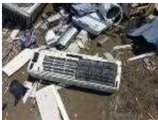
エアコン（室内機）
