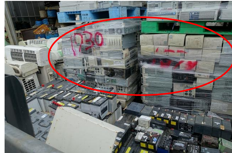
雑品スクラップ保管ヤードの現地調査 において確認されたUPS
