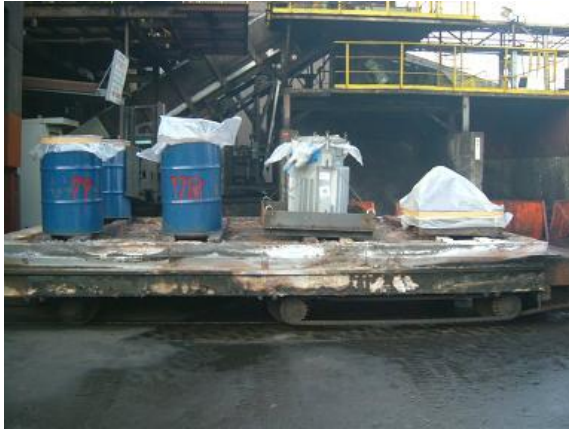
図4 変圧器及び取外したコイル、鉄心及びドラム缶
