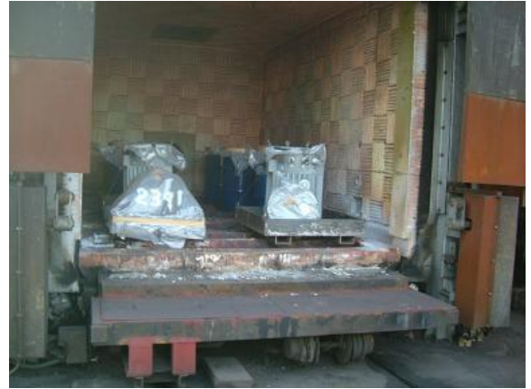
図5 炉内部への設置状況
