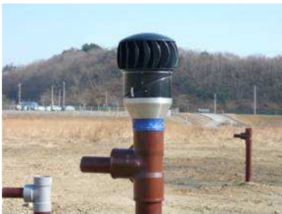
写真 3-3 自然風利用型ベンチレーター
