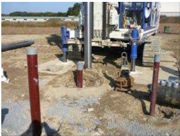
写真 3-1 STREX 工法による井戸設置状況
