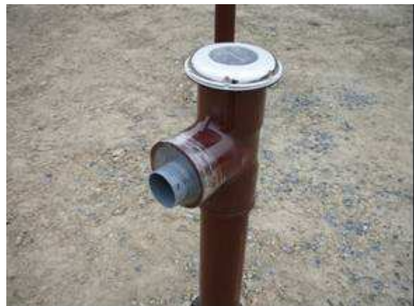
写真 3-2 太陽光利用型ベンチレーター
