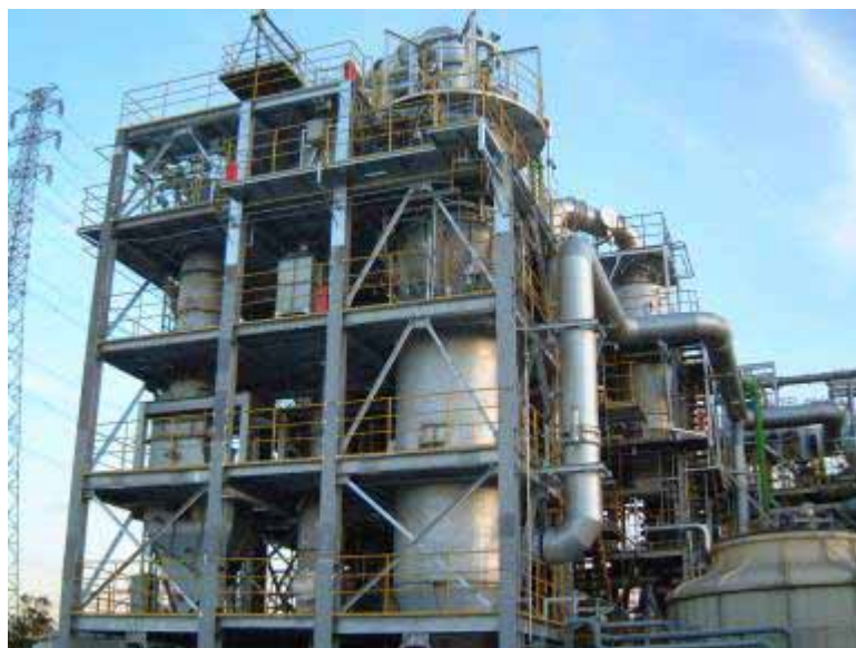
写真 実証試験設備外観
