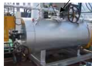
写真-16 シール部を改造したナイフゲート
