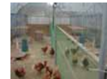
写真-13 安全性試験育雛実験棟 内部区分状況
