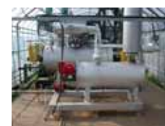
写真-20 加圧加温機と脱臭炉の配置状況
