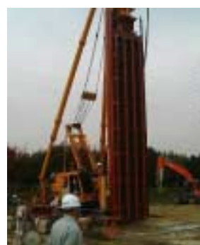
写真-4 複合シート 建込状況
