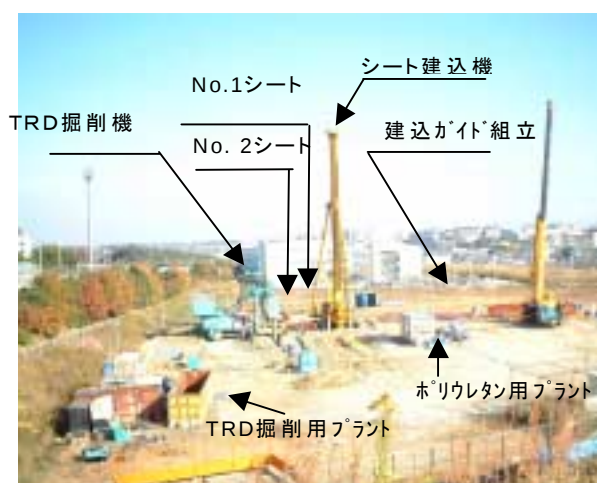
写真-3 シート建込機械配置
