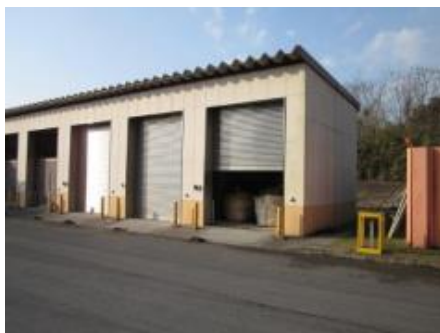
写真 2.4.1 保管庫の外観の例
