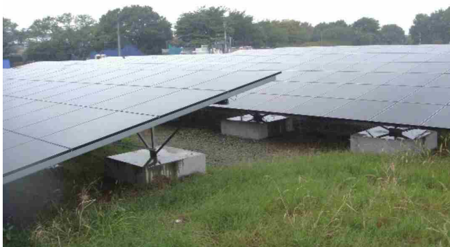
定期的な草刈りを実施（貸付面積分を事業者が、それ以外の部分を処分場管理者が担当）
