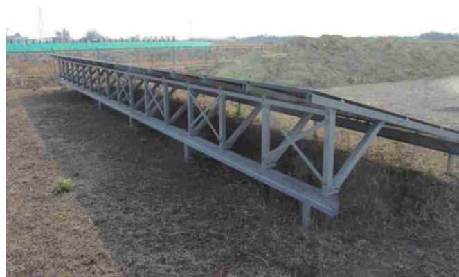
設備荷重は20kN/m 2 以下とし、設置に伴う荷重増加による処分場への影響を軽減
