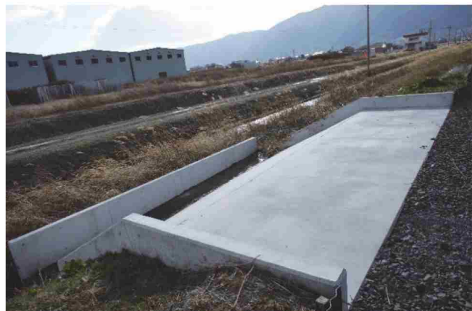
雨水は南側にある樋管から排出
