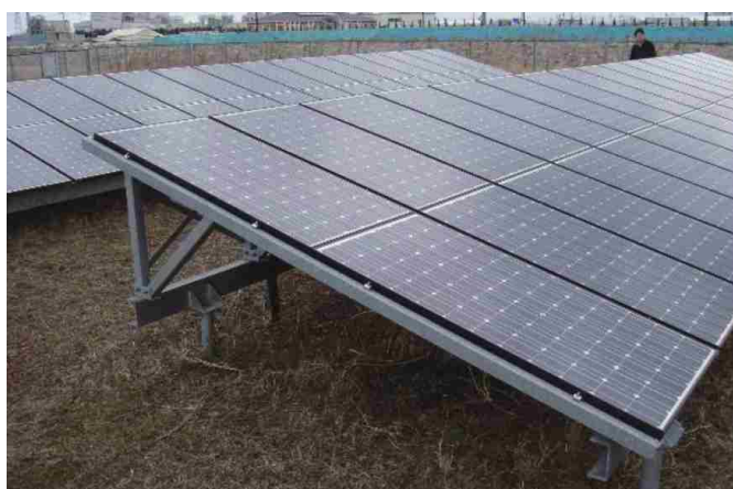
風の影響を考慮したパネルの設置
