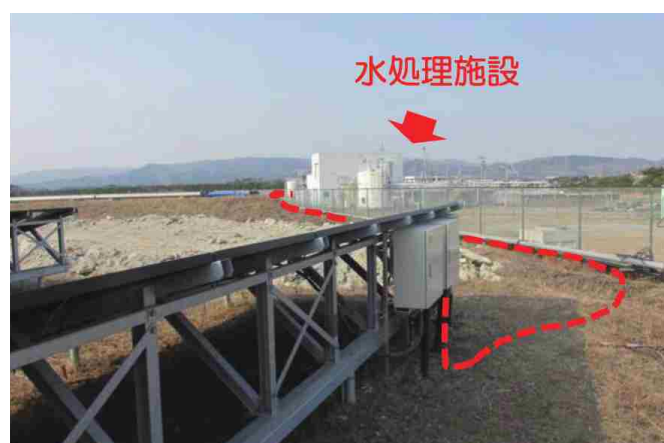
地下埋設されたケーブルにより発電した電気を水処理施設に送電
