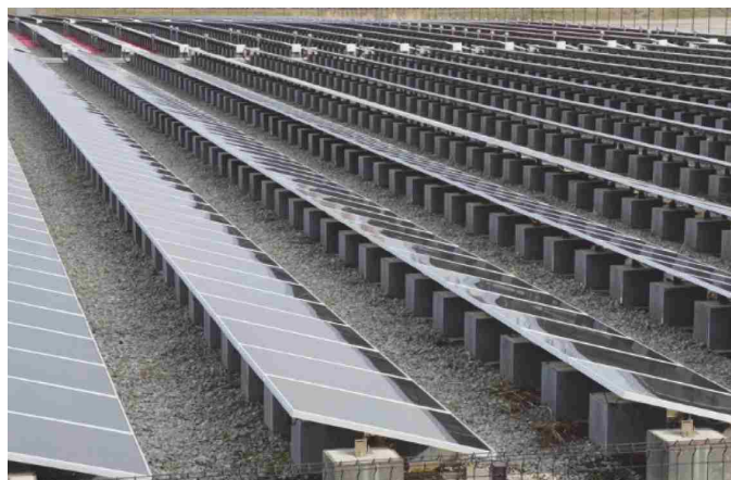
微調整可能な治具を設置
