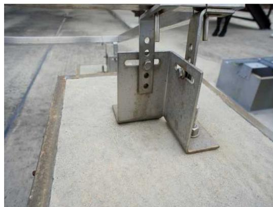
写真 5-2 高さを微調整可能な治具を設置
