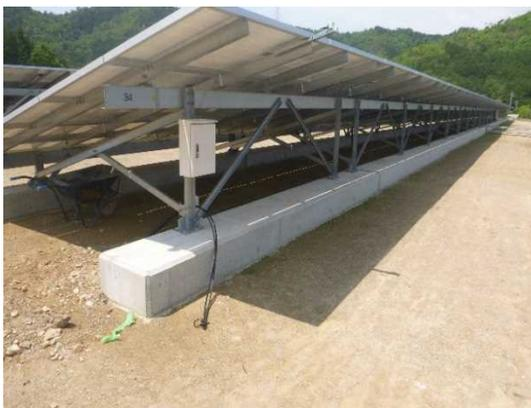
写真 5-1 連続基礎を用いた不等沈下対策
