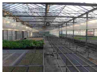
温水暖房方式農業施設
