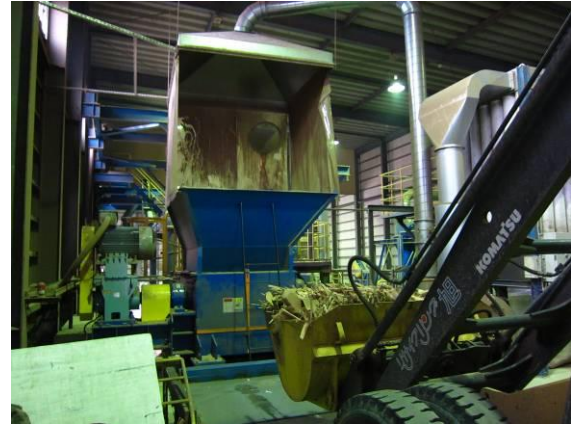
木くず投入状況
