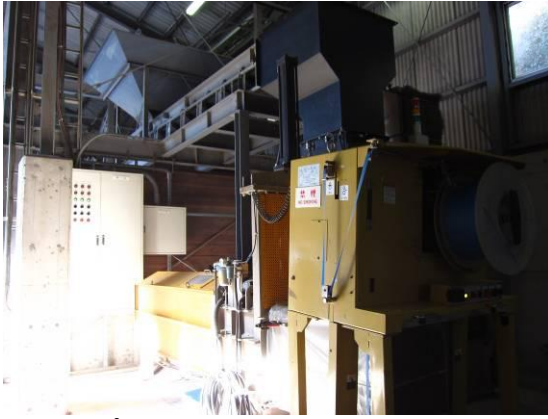
廃プラスチック燃料製造ライン
