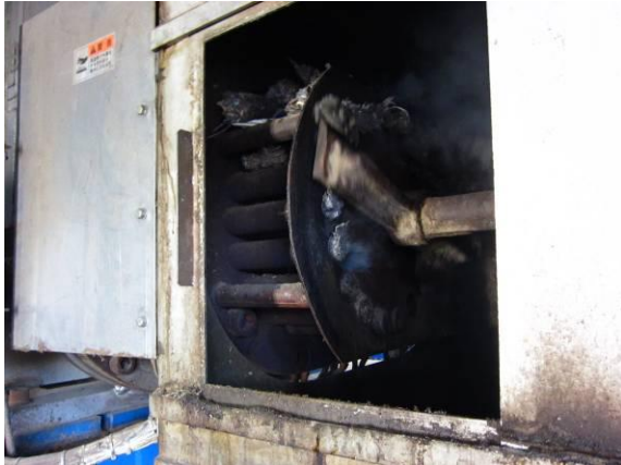
加熱圧縮状況
