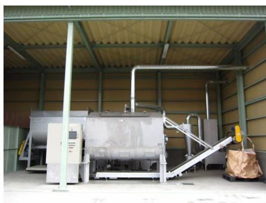
平成 23 年 4 月から稼働予定の乾燥減容機
