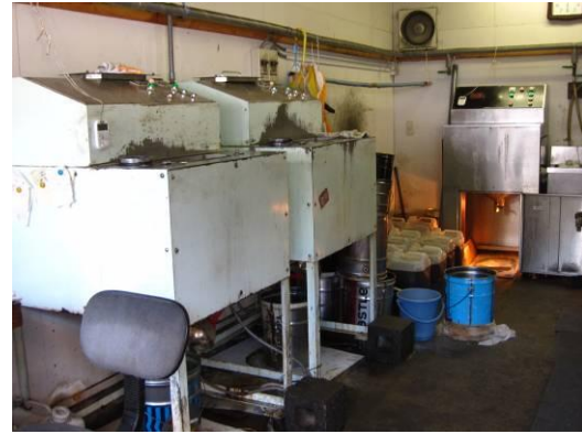
廃食油再生燃料装置
