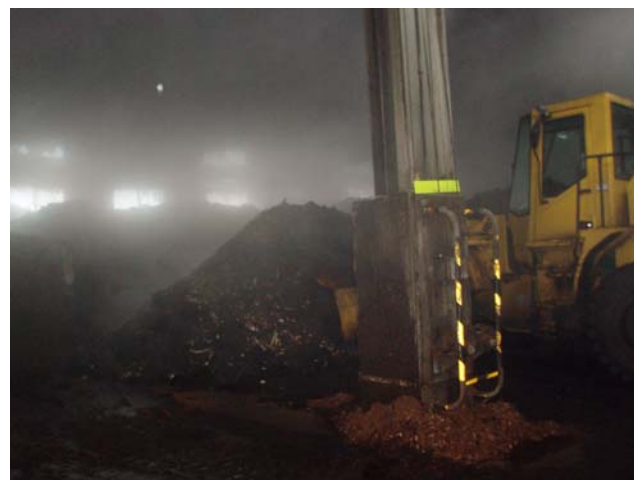
写真3-3-1 食品残さと副資材の混合状況
