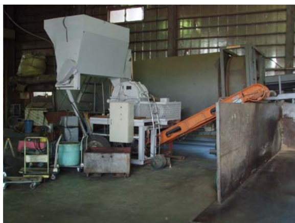
写真3-3-5① 破碎設備
