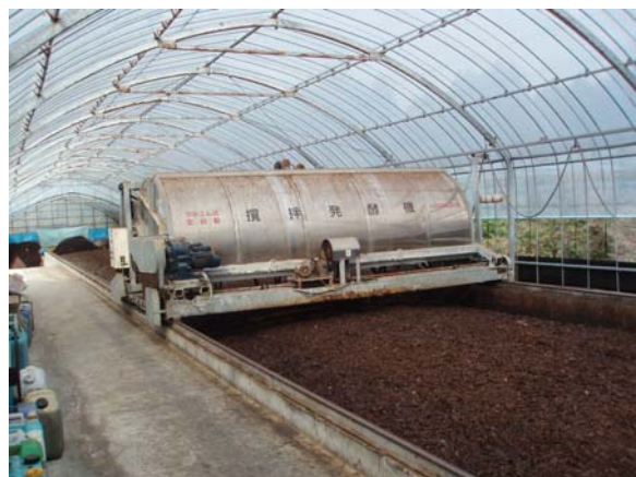
写真3-3-8② 中間発酵レーン
