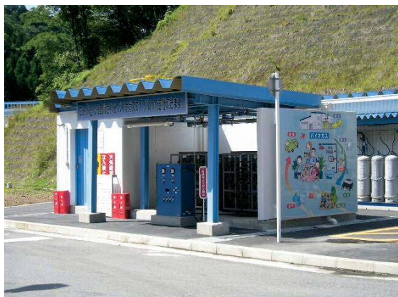
図4.2-7 バイオガススタンド
