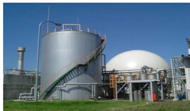
湿式メタン発酵槽（40t/d・発酵槽2槽）
