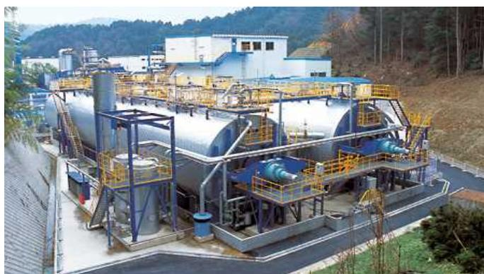
乾式メタン発酵（50t/d・発酵槽2槽）
