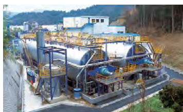
タクマ 乾式メタン発酵（50t/d） （出所）株式会社タクマ ホームページ
