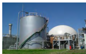
湿式メタン発酵槽（40t/d） （出所）富山県 ホームページ
