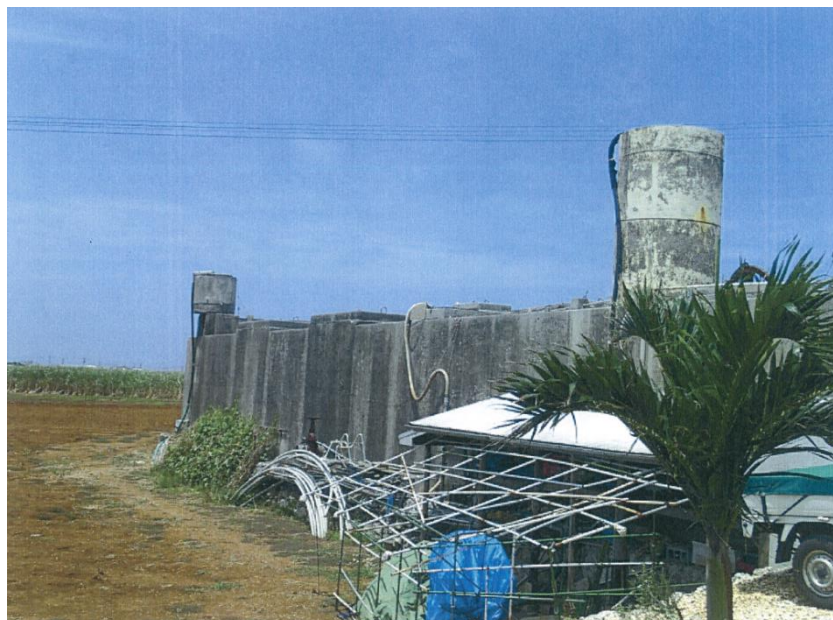
写真 3.1 し尿貯留施設
