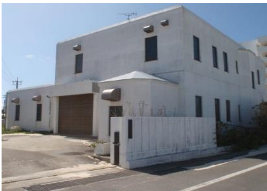
写真 3.2 与論町赤佐地区農業集落排水処理施設
