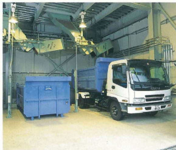
■ 搬出ヤード (アームロールコンテナ式)
