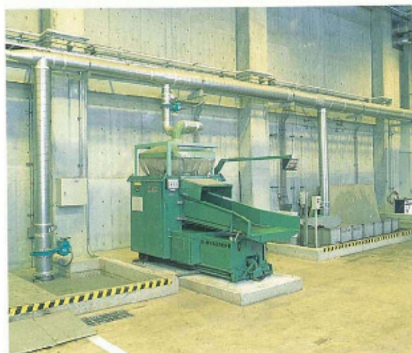
■プラットホーム
