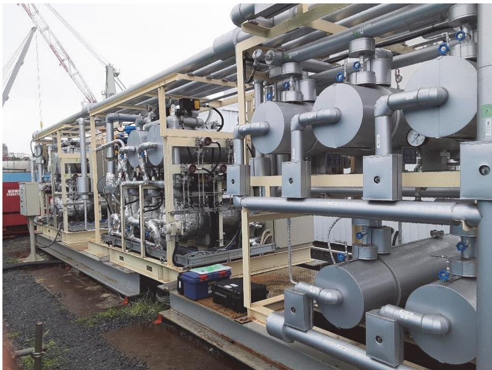
図 2-4-3 実証試験 2 で用いた CO<sub>2</sub> 膜分離装置の写真
