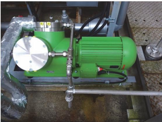
図 2-3-2 ガス昇圧装置
