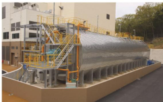
図 2-1-7 高温乾式メタン発酵槽
