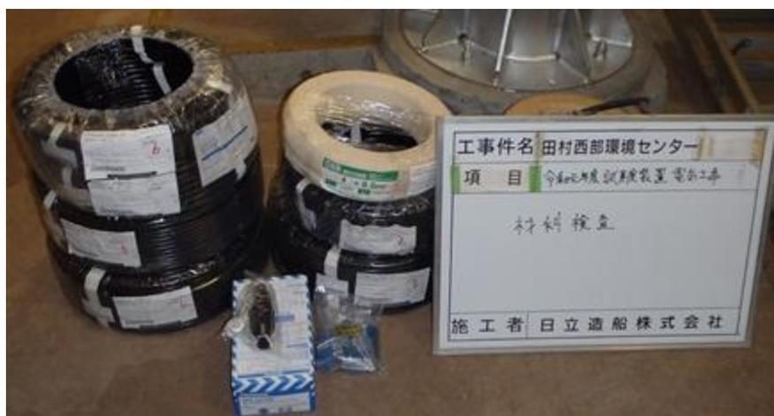
図 2-5 電気工事の材料検査
