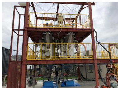
メタン発酵処理設備
