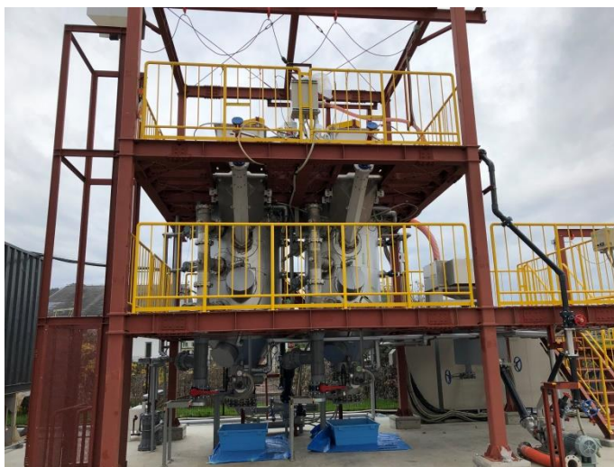
写真 2-2-10 メタン発酵設備
