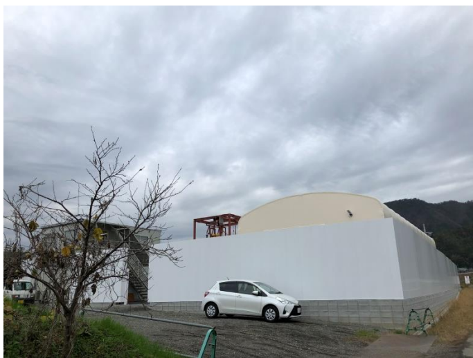
写真 2-2-6 施設外観（裏面）
