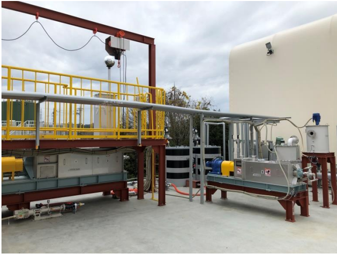
写真 2-2-11 脱水処理設備
