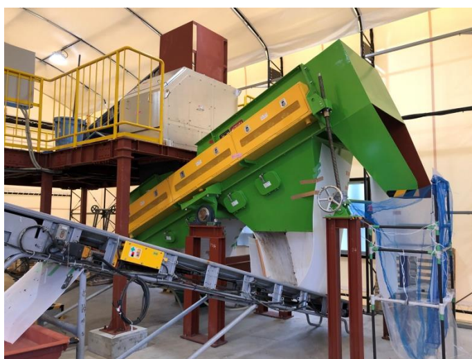
写真 2-3-9 破袋機＋選別機
