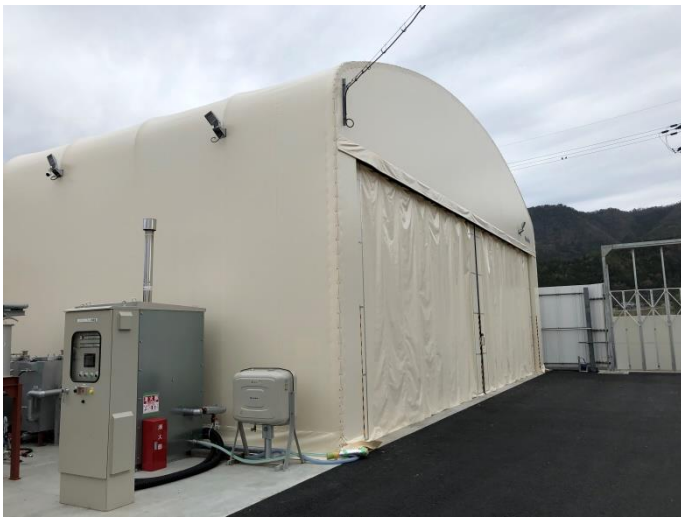
写真 2-2-12 倉庫棟（ごみヤード）
