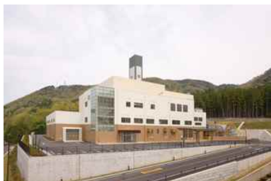
図 2-2-1 高効率原燃料回収施設棟
