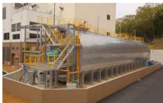
図 2-2-2 メタン発酵槽 (高温乾式メタン発酵)
