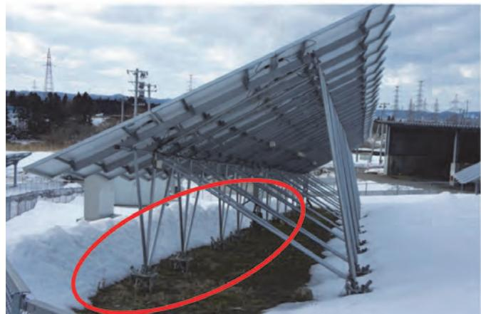
表土流出対策のため雨水が直接当たるパネル下に草丈の低い植物を植栽
