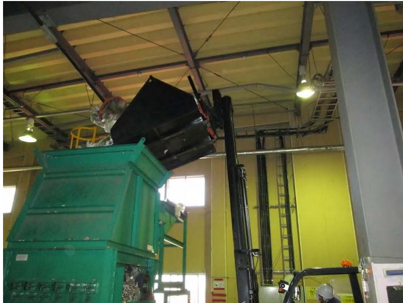
図 4-8 プラスチックを投入するためのバケットを取り付けたフォークリフト
