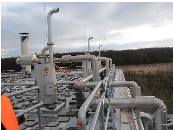
写真 D-5 メタン発酵/発酵槽建屋屋上
