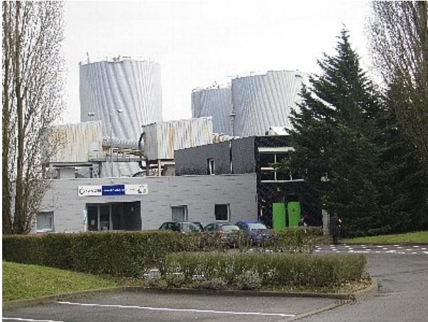
写真 F-1 施設外観
