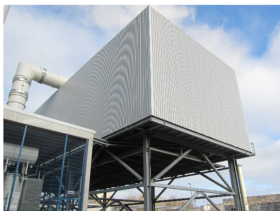
写真 E-5 蒸気コンデンサ
