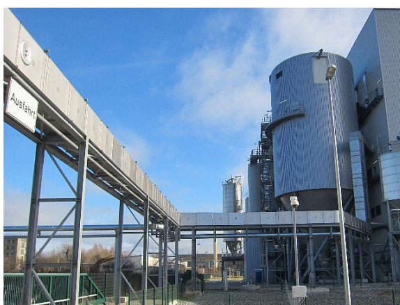
写真 E-10 MBT 施設からの 排ガスライン・熱供給ライン
