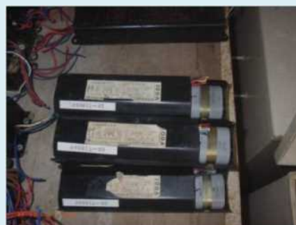
PCB含有のコンデンサ部分の取り外し作業
