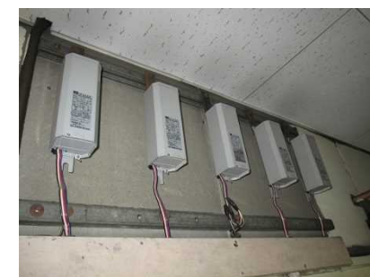
工場等の壁際に設置されている例
