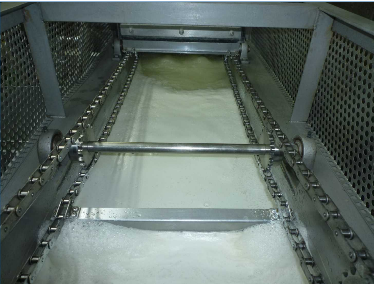
排水处理設備
