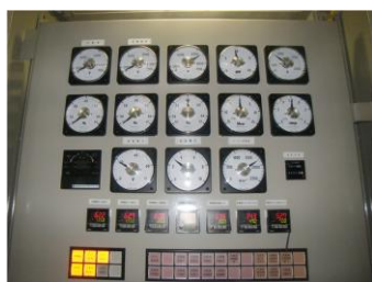
写真8 発電機監視盤
