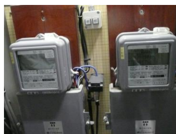
写真2 買電用と売電用電力量計
