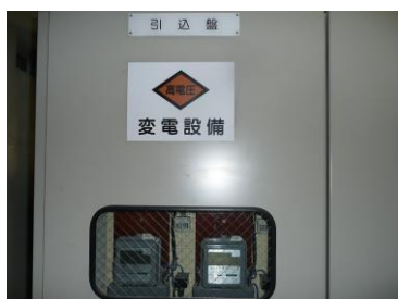
写真1 電力量計引込盤
