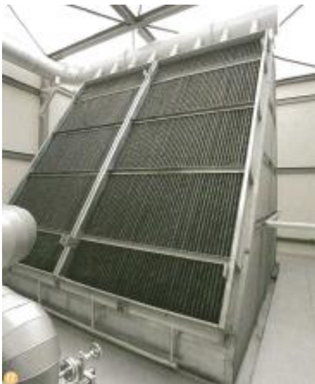
(4) 蒸気復水器の外観写真例
