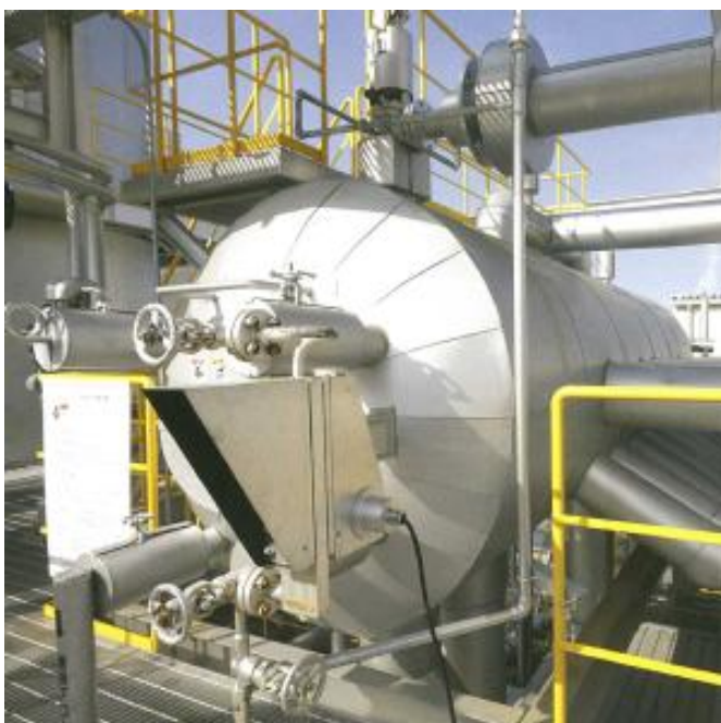
(4) 蒸気復水器の外観写真例
